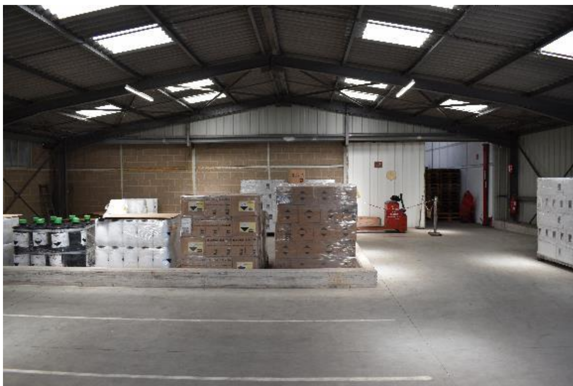
Figure 10 : Stockage bâtiment logistique
