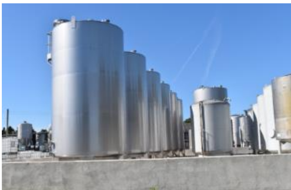
Figure 9 : Rétention de solvants
