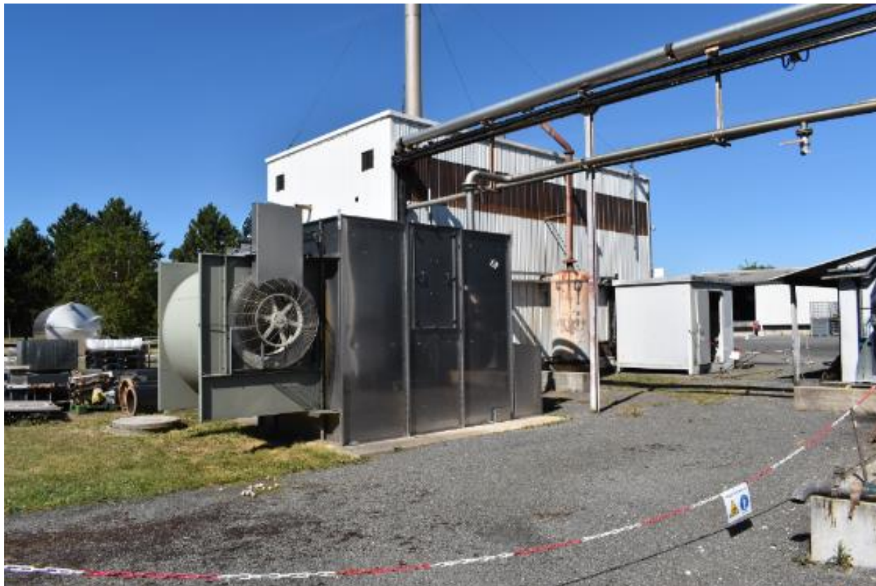
Figure 15 : Tour aéroréfrigérante
